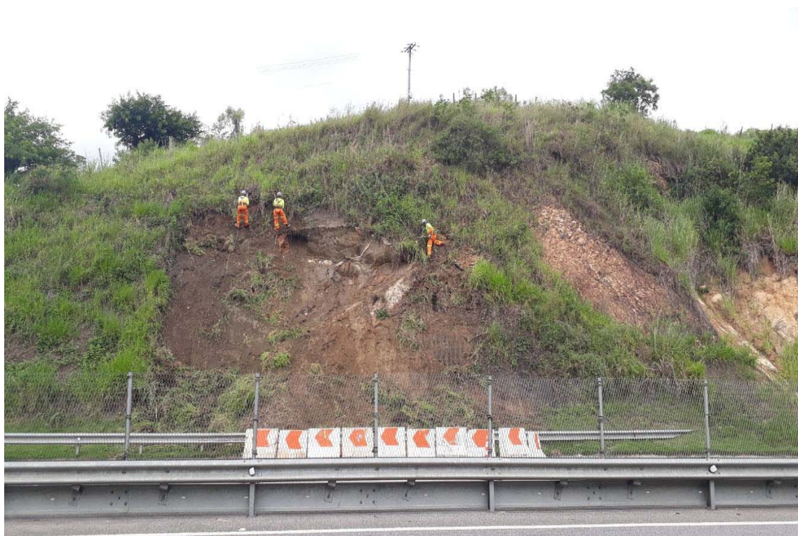
FOTO 21 - Obra de Recuperação de Talude - Km 5+700 Norte F1
