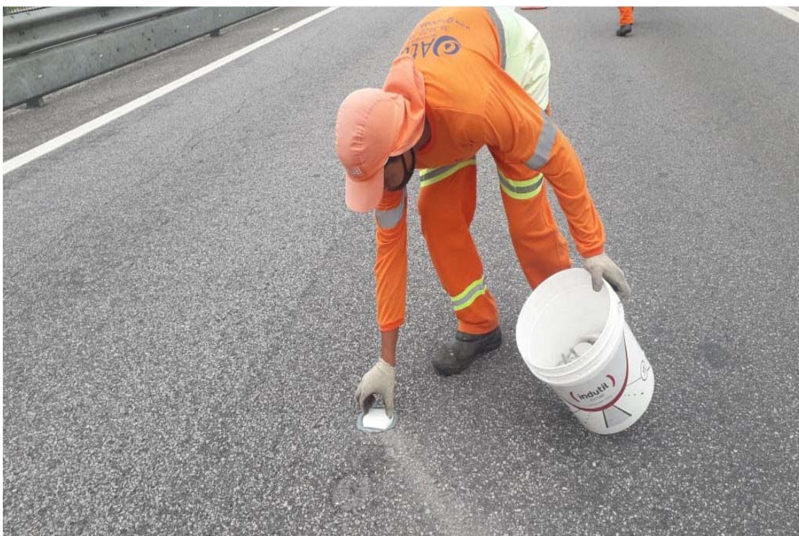
FOTO 06 - Implantação de Tachas - Km 15+200 Norte F2
