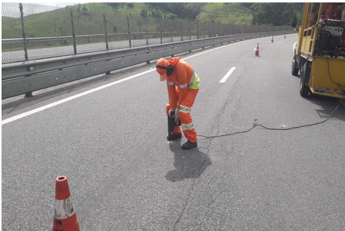
FOTO 05 - Implantação de Tachas - Km 15+200 Norte F1
