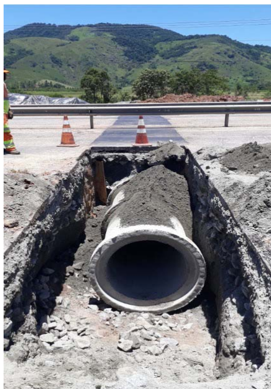
FOTO 24 - Obra de Ampliação de Drenagem - Km 11+514 Norte F2
