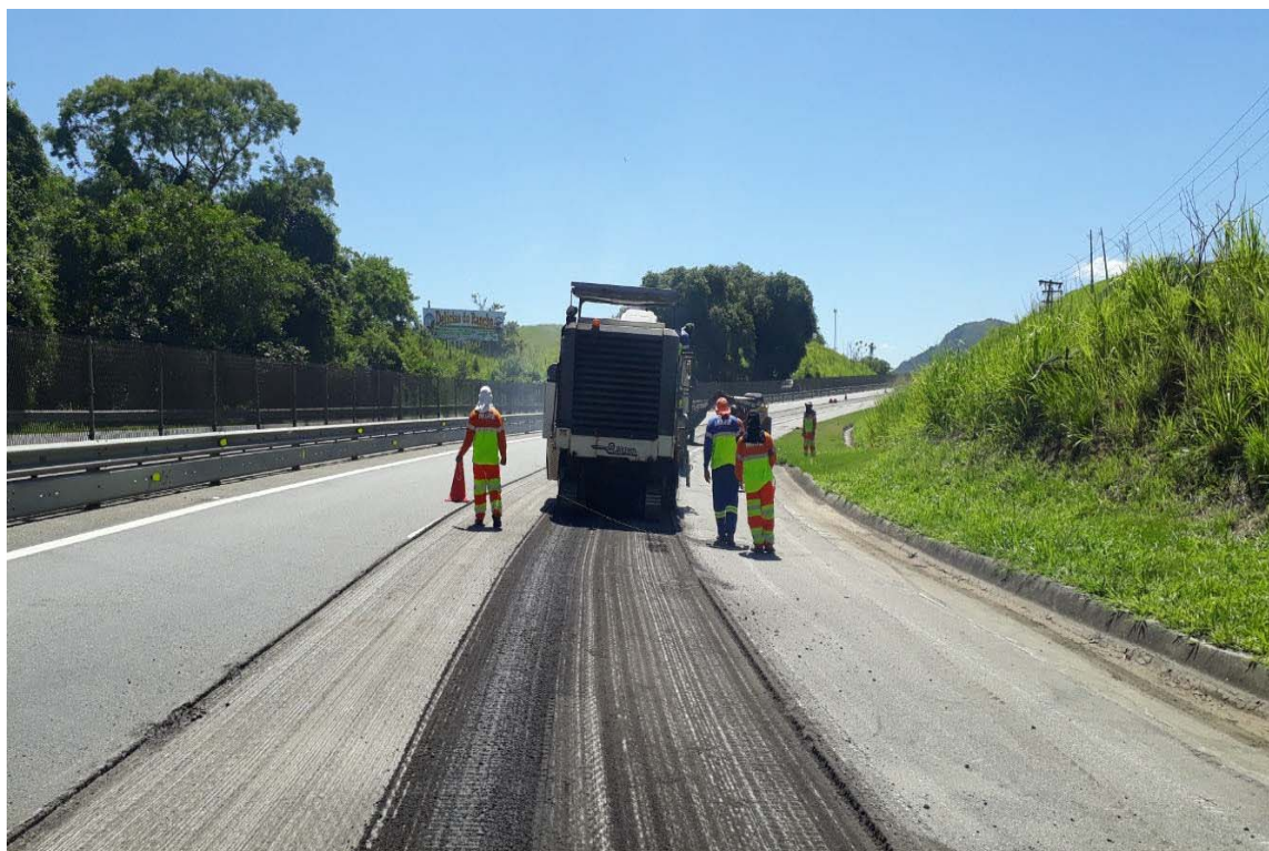
FOTO 29 - Obra de Recuperação do Pavimento - Km 10+600 Norte F1
