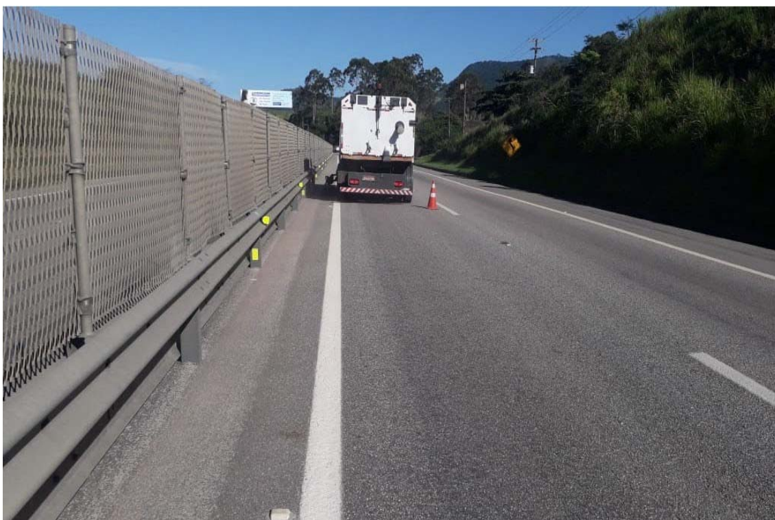
FOTO 14 - Varrição de Mediana - Km 10+500 Norte F1
