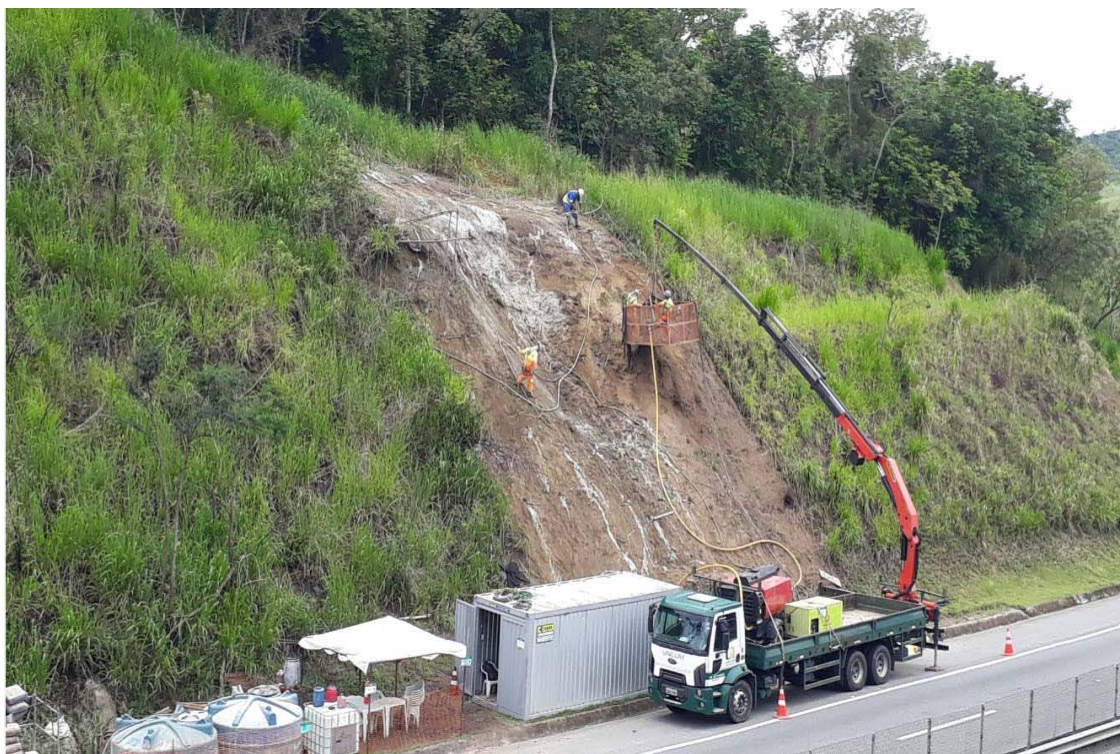
FOTO 19 - Obra de Recuperação de Talude - Km 5+200 Sul F2
