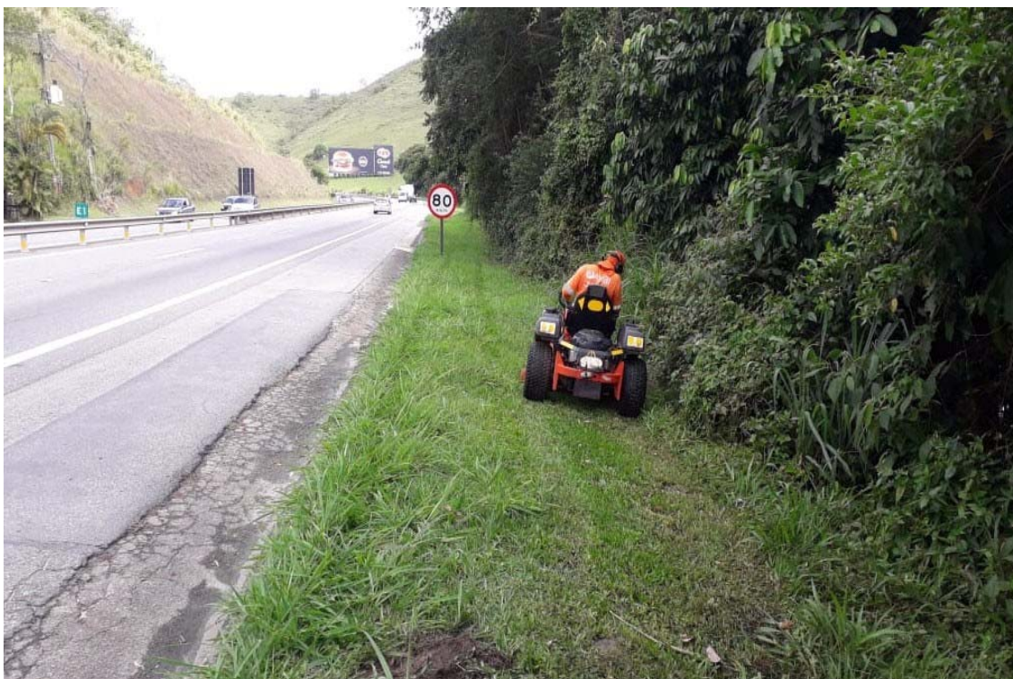
FOTO 13 - Roçada Mecânica - Km 2+000 Norte F1
