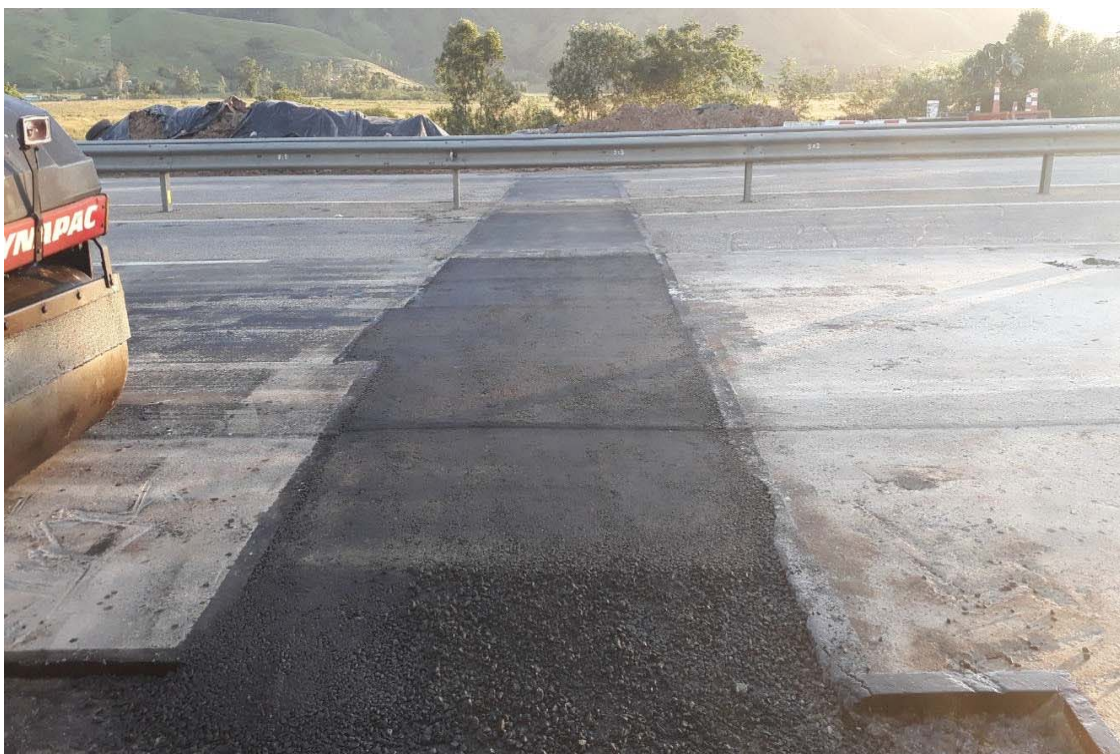
FOTO 25 - Obra de Ampliação de Drenagem - Km 11+514 Norte F3
