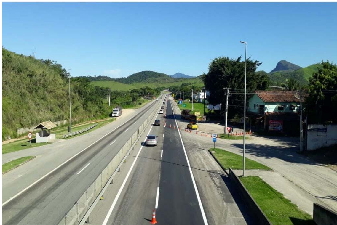
FOTO 27 - Obra de Recuperação do Pavimento - Km 3+500 Norte F2
