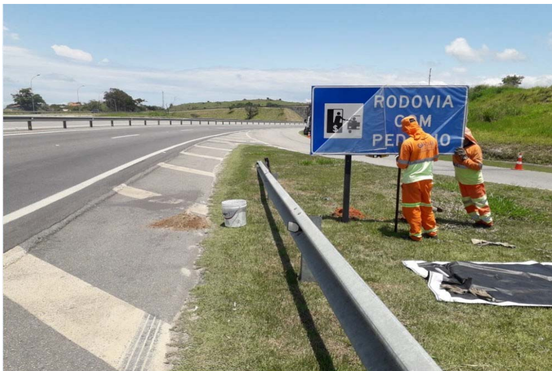
FOTO 03 - Substituição de Placa - Km 57+000 Sul F1
