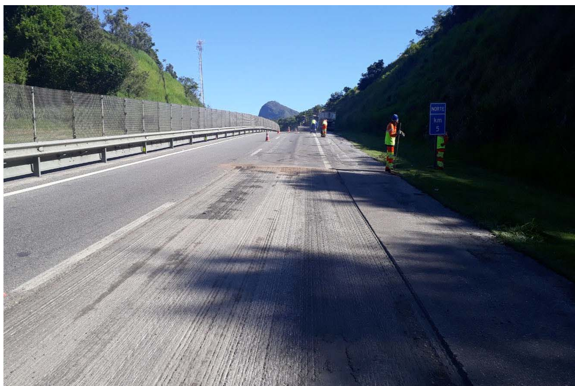
FOTO 28 - Obra de Recuperação do Pavimento - Km 5+000 Norte F1
