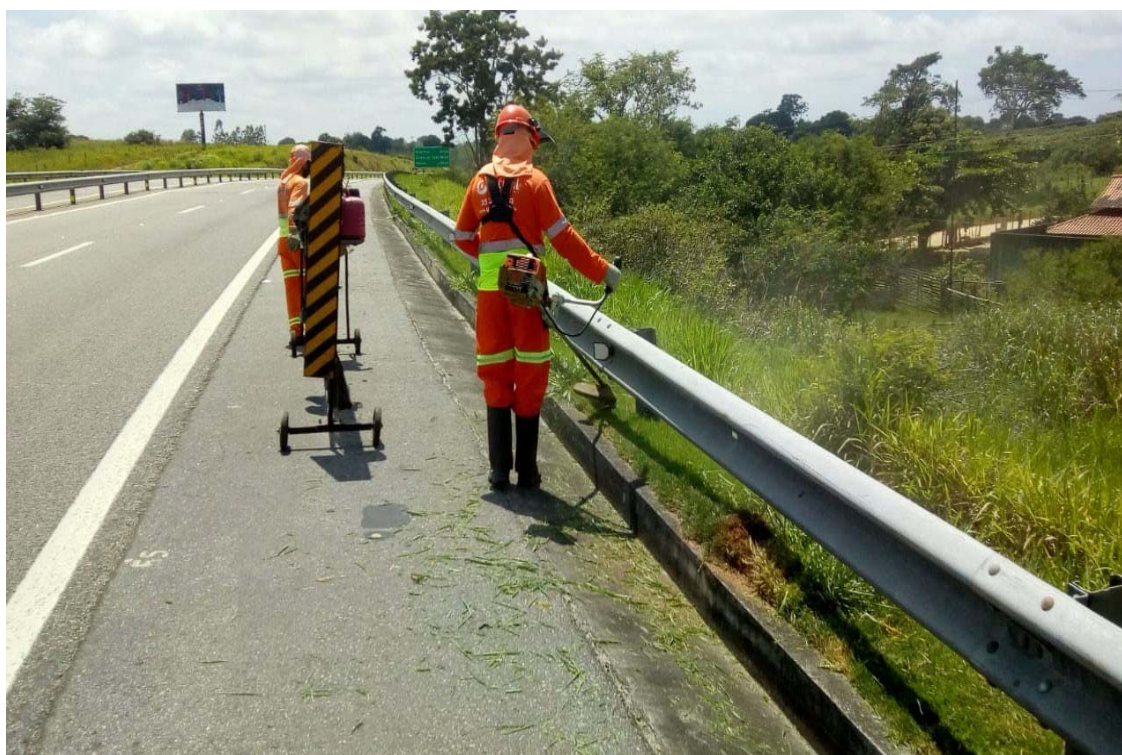
FOTO 12 - Roçada Manual - Km 30+200 Norte F1
