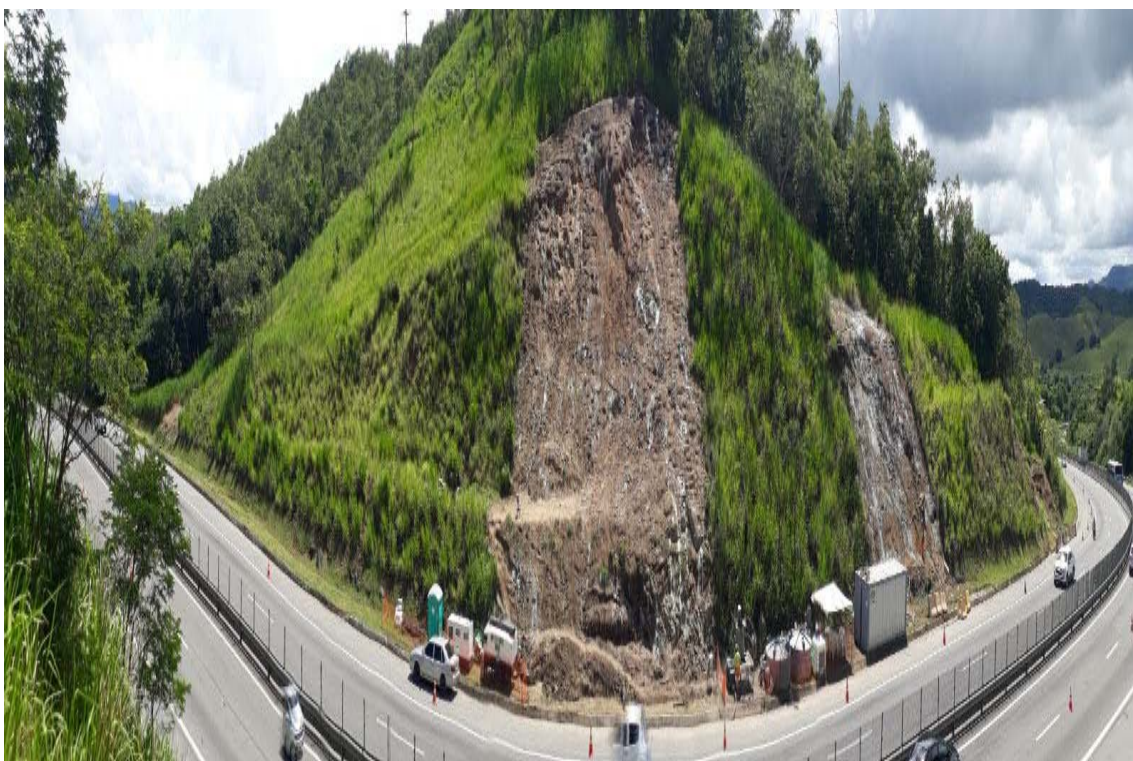
FOTO 20 - Obra de Recuperação de Talude - Km 5+200 Sul F3
