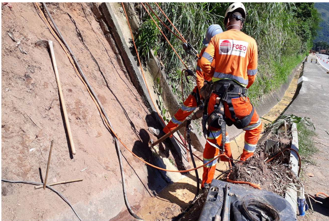
FOTO 17 - Obra de Recuperação de Talude - Km 1+300 Norte F2
