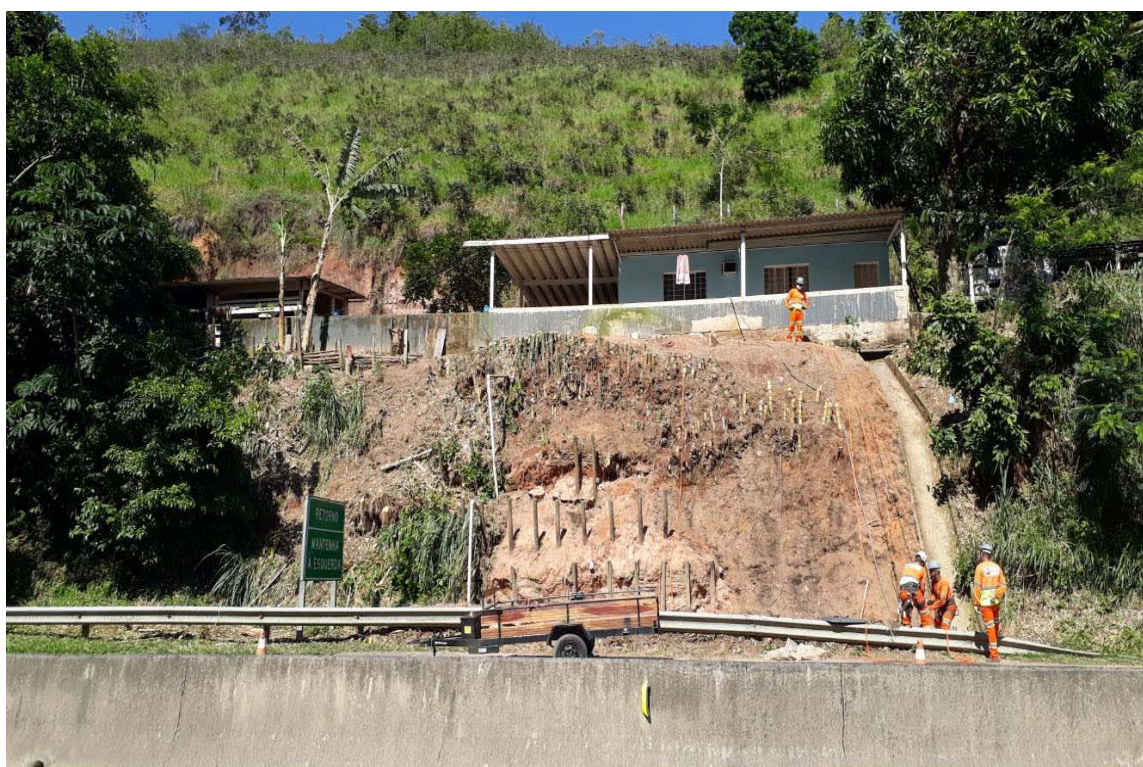
FOTO 16 - Obra de Recuperação de Talude - Km 1+300 Norte F1
