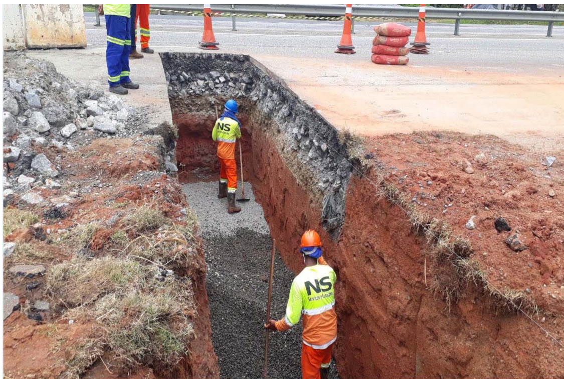
FOTO 23 - Obra de Ampliação de Drenagem - Km 11+514 Norte F1
