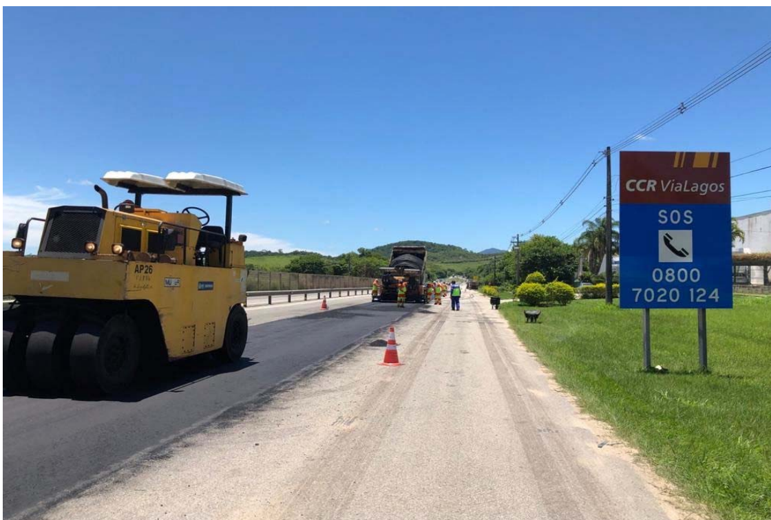
FOTO 26 - Obra de Recuperação do Pavimento - Km 3+500 Norte F1
