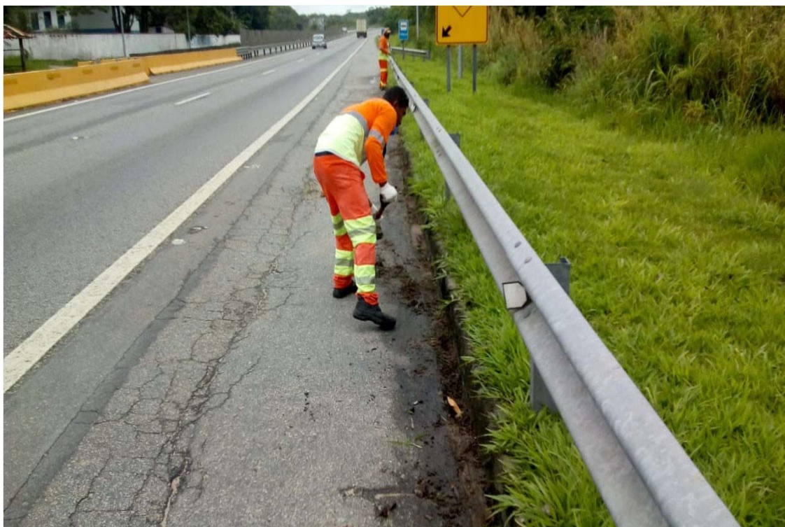
FOTO 10 - Limpeza Sarjeta - Km 26+100 Sul F1
