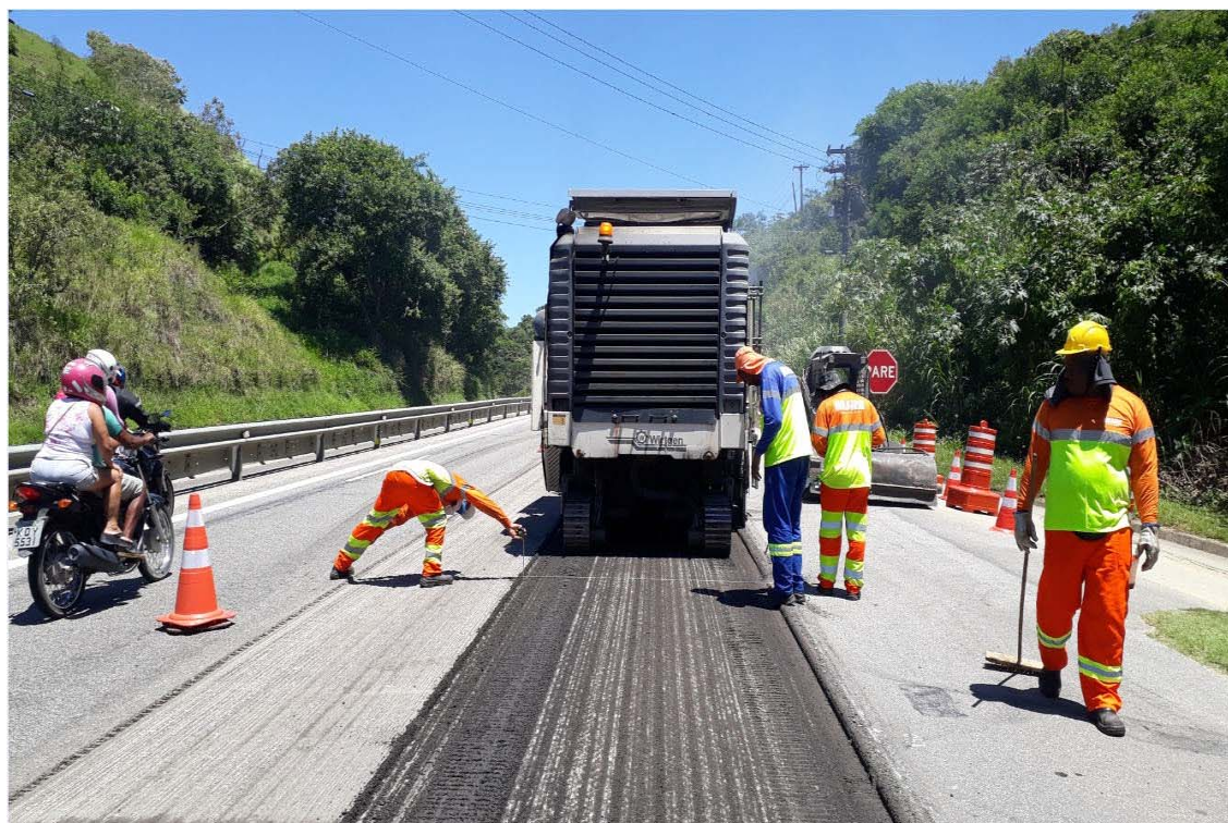
FOTO 30 - Obra de Recuperação do Pavimento - Km 2+000 Sul F1
