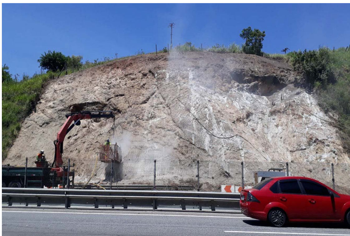
FOTO 22 - Obra de Recuperação de Talude - Km 5+700 Norte F2
