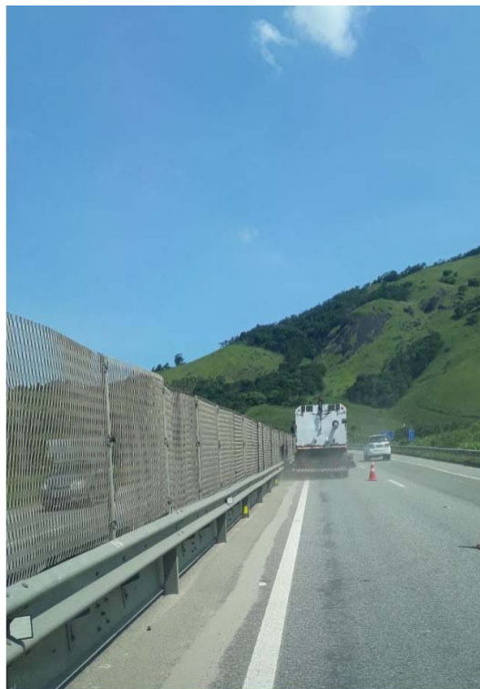
FOTO 15 - Varrição de Mediana - Km 17+000 Norte F1
