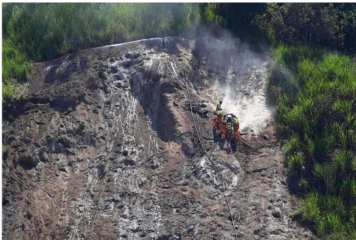
FOTO 18 - Obra de Recuperação de Talude - Km 5+200 Sul F1
