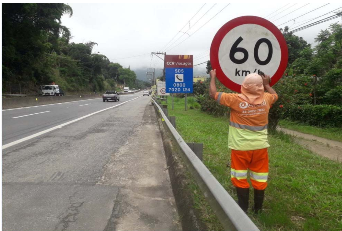
FOTO 04 - Limpeza de Placa - Km 1+500 Sul F1
