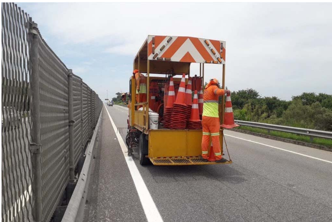
FOTO 02 - Pintura de Faixas - Km 28+000 Norte F2
