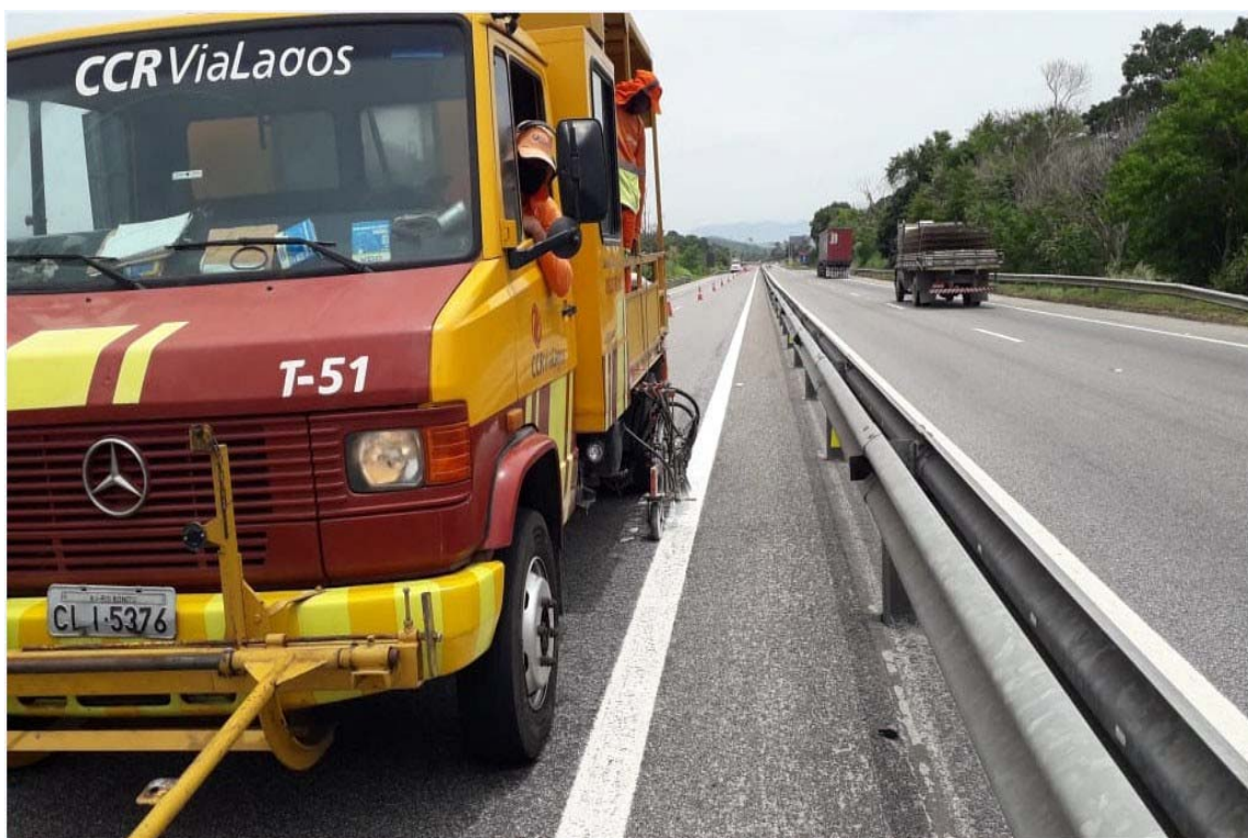
FOTO 01 - Pintura de Faixas - Km 28+000 Norte F1
