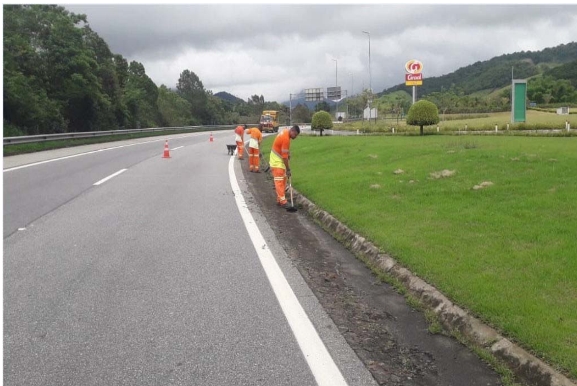
FOTO 09 - Limpeza Sarjeta - Km 23+000 Norte F1
